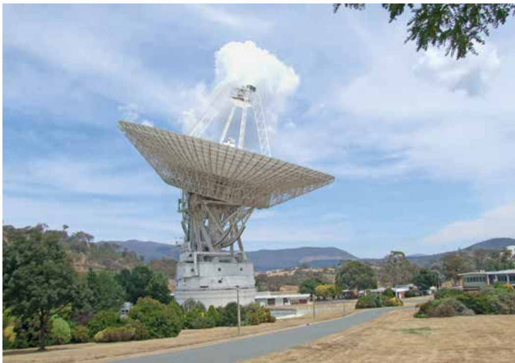
Anteno DSS43 apud la spaca centro en Tidbindilla. La 70 metrojn larĝa telero malrapide moviĝas.
