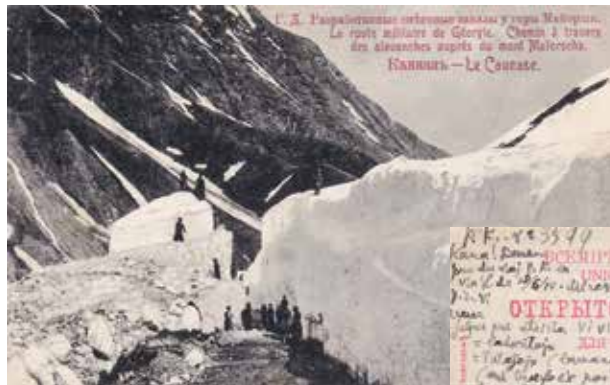
Trafosado de profunda lavango
